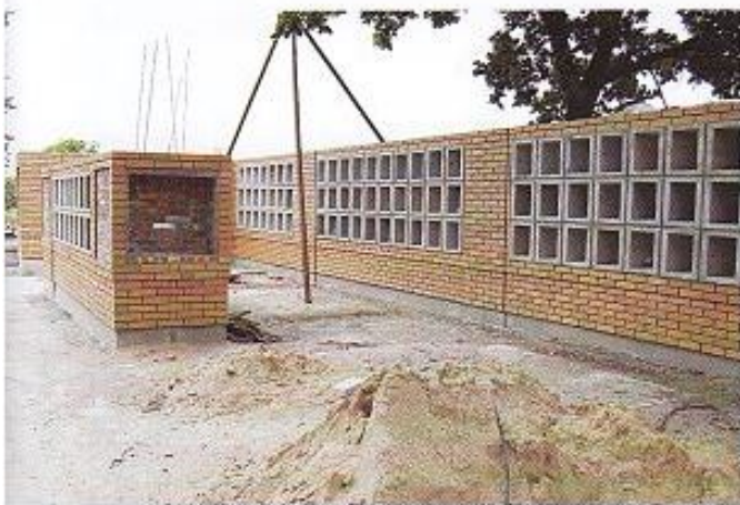
Białskie kolumbarium w budowie (czerwiec 2007 r.).
