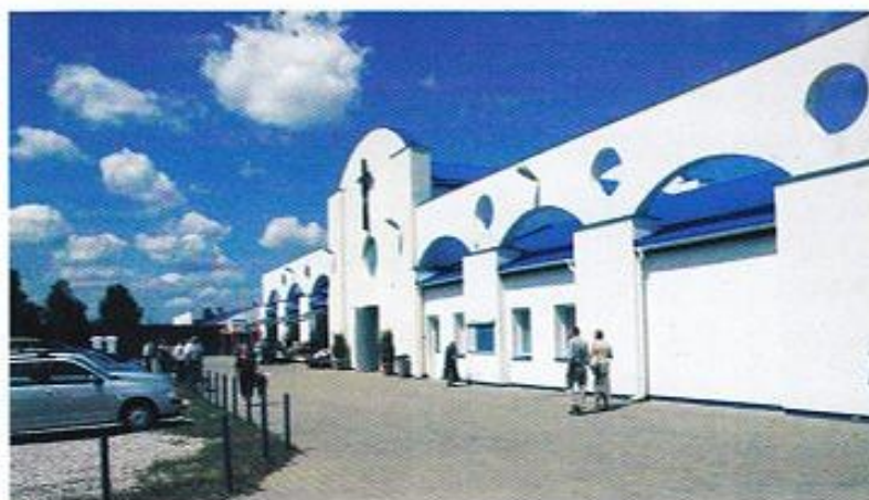
Kaplica pogrzebowa w sąsiedztwie krematorium.
