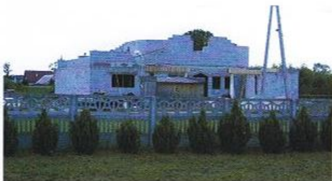
Dom pogrzebowy państwa Ważyńskich w budowie.
